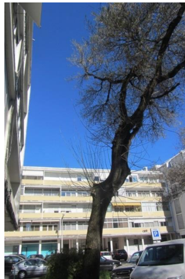
Fig. 8 – Inclinação do tronco para a zona de estacionamento.
